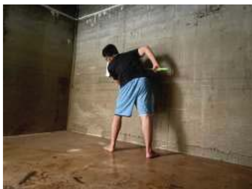
ล้างทำความสะอาดถังเก็บน้ำสำรองน้ำใช้ ภาพที่ 2.2-6 (ต่อ) การบริหารจัดการระบบน้ำใช้
