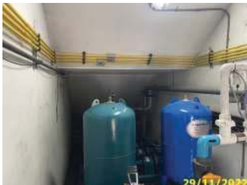
ระบบปั้มน้ำอาคารสโมสร
